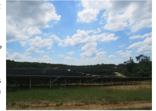
Parc photovoltaïque voisin, au sud de la ZIP
