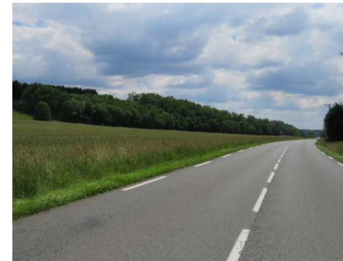
La RD 78 aux abords de la carrière de « Boudeau »
