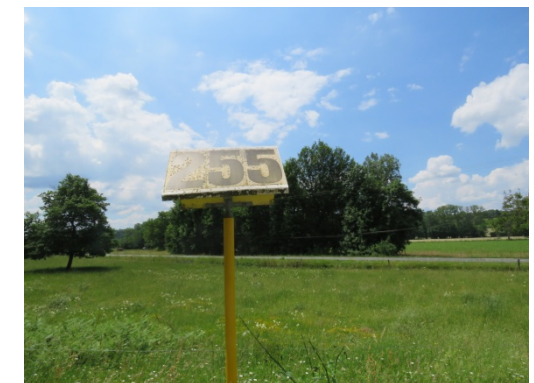
Borne et panneau de signalisation de la canalisation de gaz naturel à l'ouest du lieu-dit « Les Braudies »
