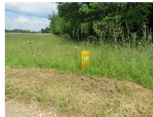
Borne et panneau de signalisation de la canalisation de gaz naturel à l'ouest du lieu-dit « Les Braudies »
